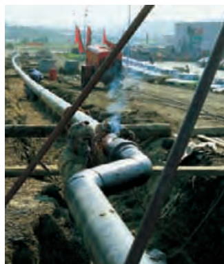
Schweißnaht-Bearbeitung an einer Pipeline mit der gezipften Ultra Einzel-scheiben-Bürste.
