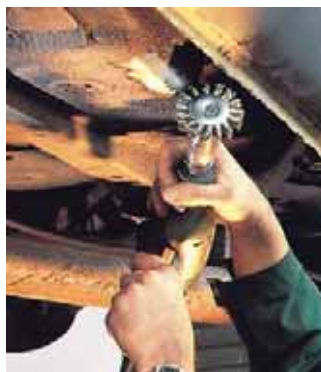
Entfernen von Unterbodenschutz mit einer Ultra Schafrundbürste.
