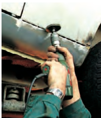
Schweißnahtbearbeitung mit einer Delta Schaftgrundbürste.
